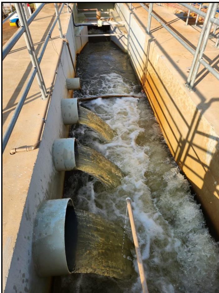
Figura 25 - Mistura Rápida - Calha Parshall na chegada da ETA
