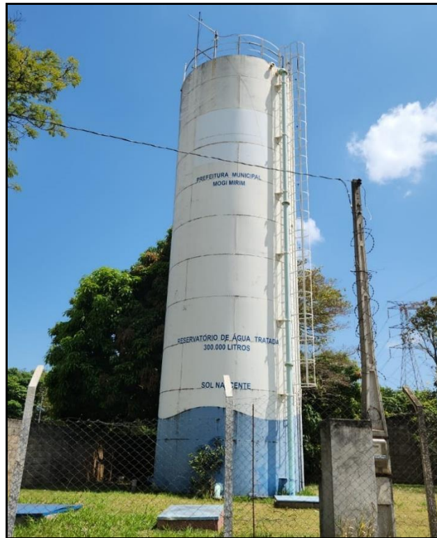
Figura 56 - Reservatório Chácaras Sol Nascente
