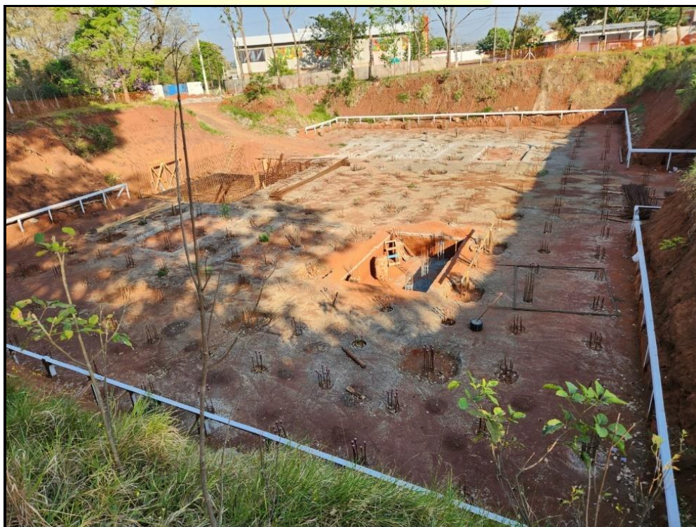
Figura 23 - Reservatório em construção – 5.000 m 3
