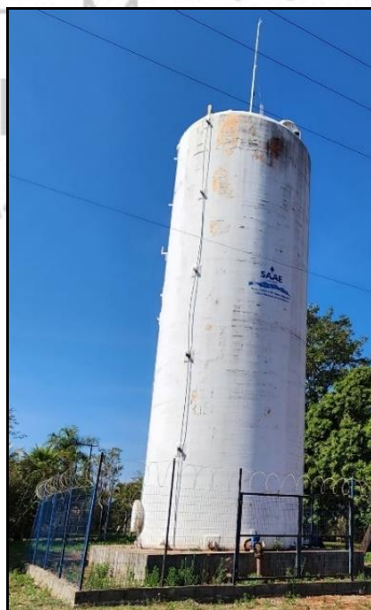
Figura 59 - Reservatório Chácaras Paraíso da Cachoeira
