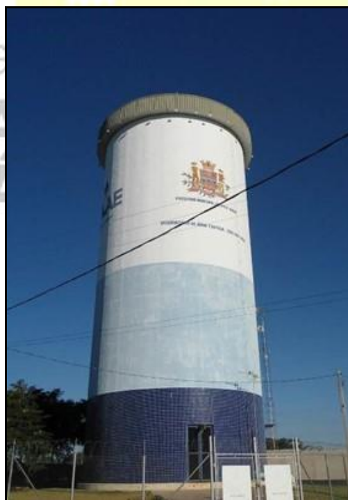
Figura 44 - Reservatório do Parque Real
