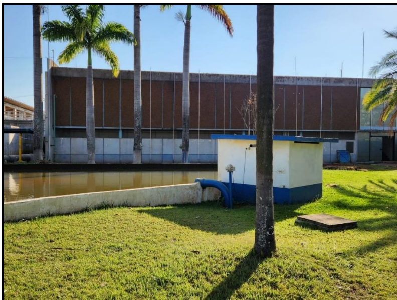
Figura 20 - Estação de Tratamento de Água
