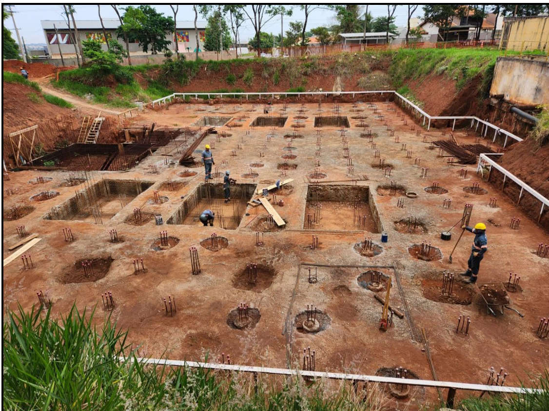
Figura 37 - Reservatório de 5.000 m³ em construção
