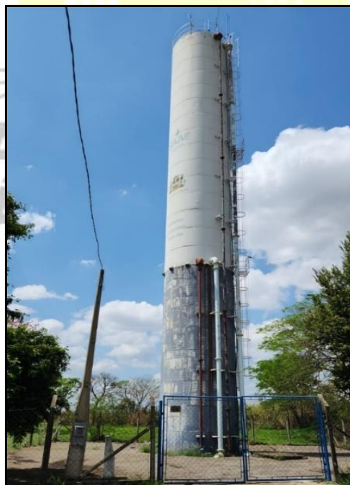
Figura 57 - Reservatório Martim Francisco
