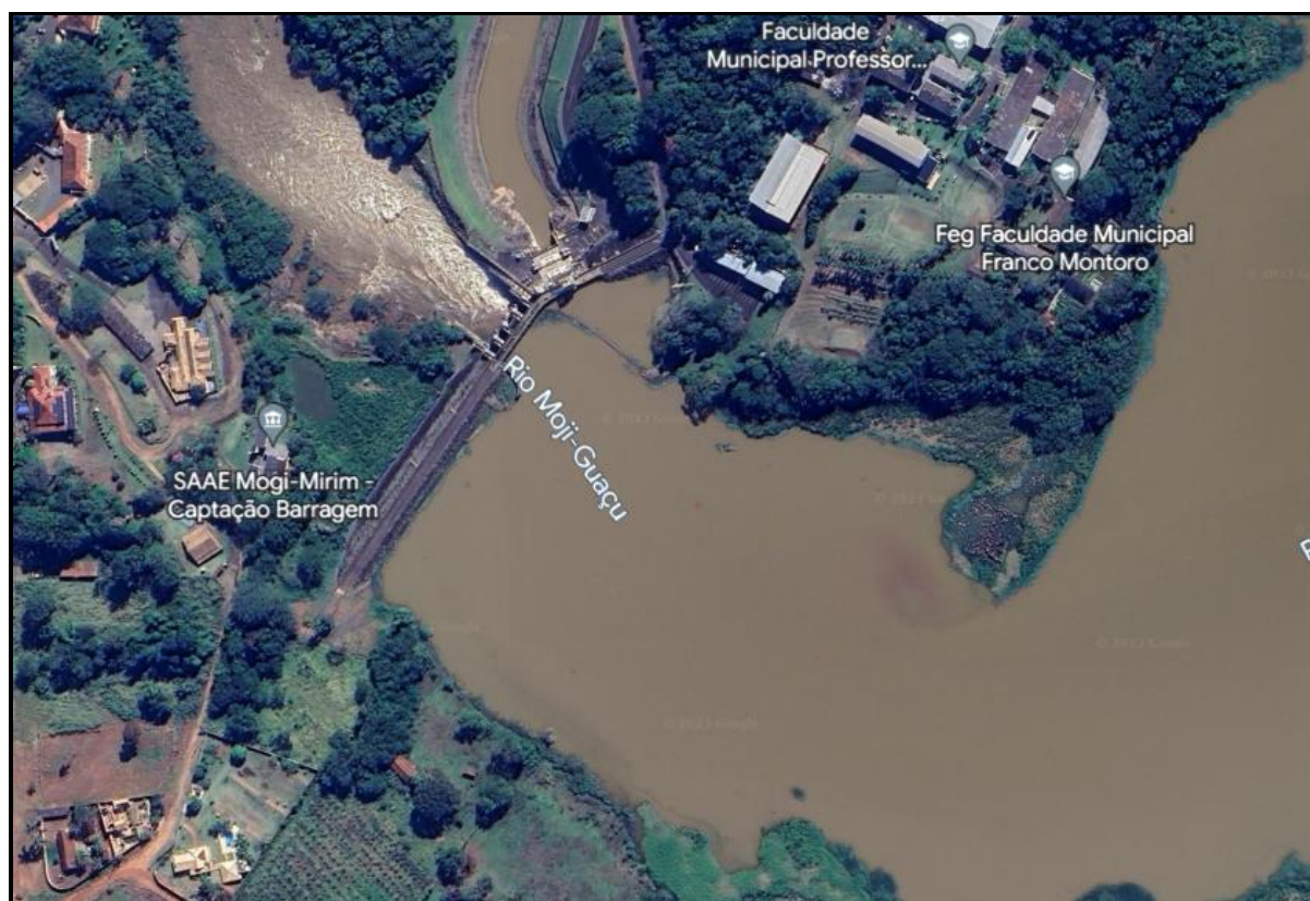
Figura 11 - Localização da Captação de água bruta
