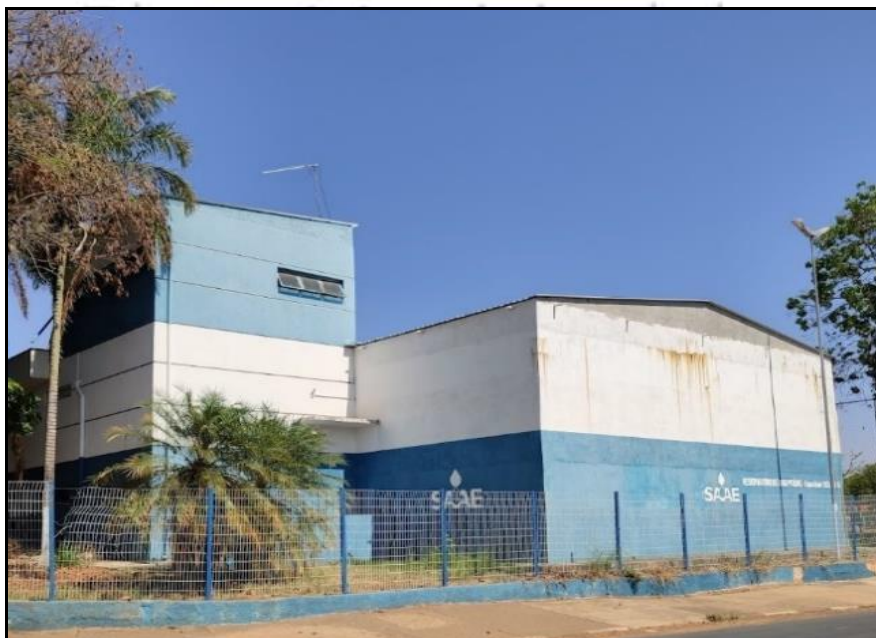
Figura 46 - Reservatório Catarino Marangoni
