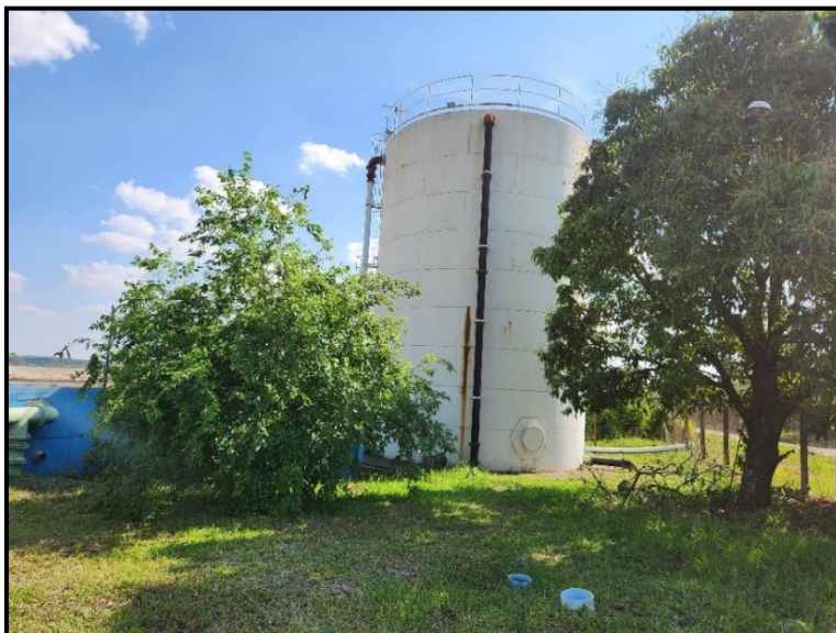
Figura 55 - Reservatório apoiado do Parque das Empresas
