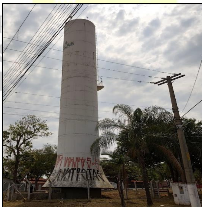
Figura 53 - Reservatório do Chico Mendes
