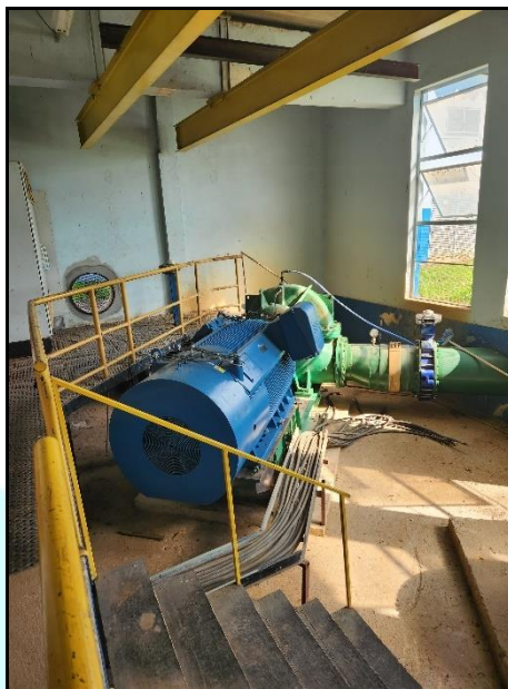
Figura 14 - Conjunto Motor-Bomba 3
