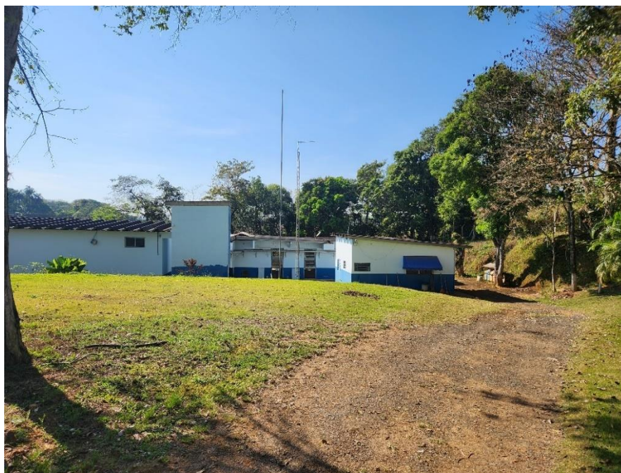
Figura 12 - Vista externa da EEAB
