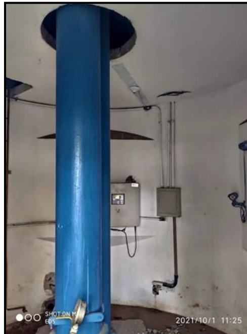
Figura 52 - Parte interna do reservatório do Cálice
