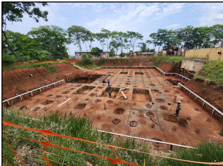
Figura 24 - Reservatório em construção – 5.000 m 3
