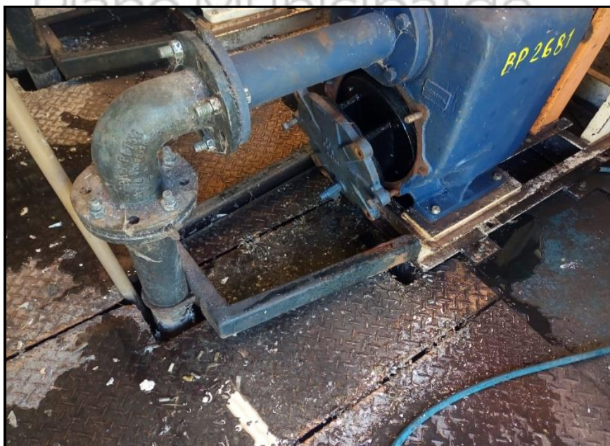
Figura 1 - Manutenção preventiva na Elevatória Linda Chaib
