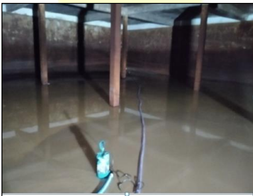
Figura 5 - Limpeza do reservatório da ETA
