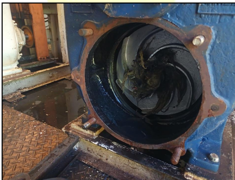
Figura 3 - Manutenção preventiva na Elevatória Linda Chaib
