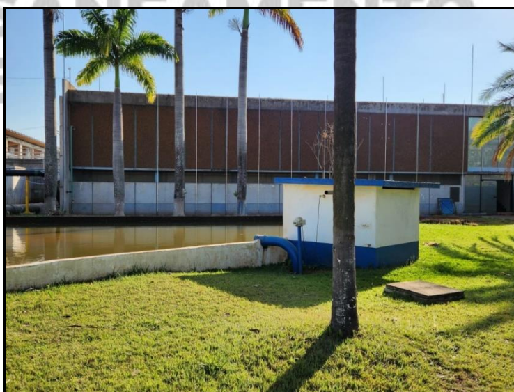
Figura 9 - Estação de Tratamento de Água
