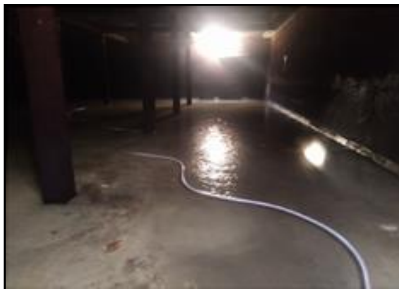
Figura 4 - Limpeza do reservatório da ETA
