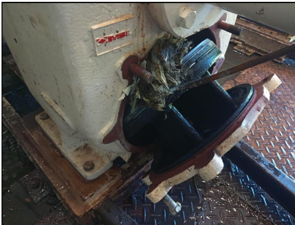
Figura 2 - Manutenção preventiva na Elevatória Linda Chaib
