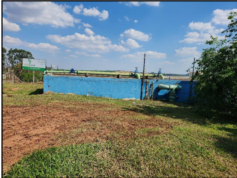
Figura 78 - Reservatório semienterrado do Parque das Empresas
