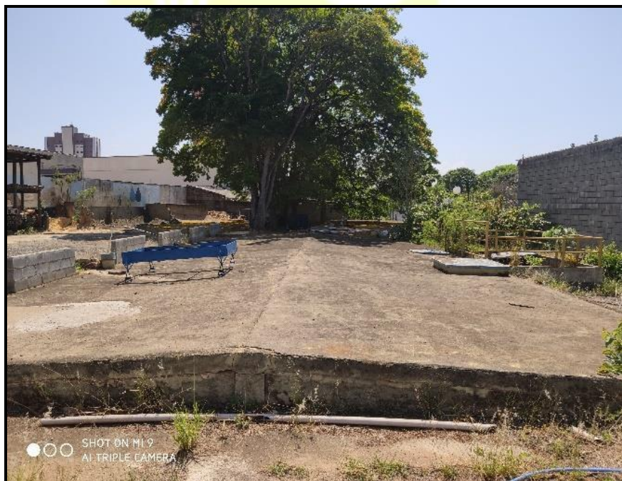
Figura 51 - Reservatório retangular da Sede (estaleiro)
