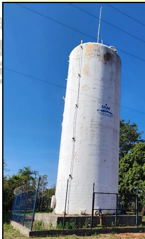
Figura 88 - Reservatório Chácaras Paraíso da Cachoeira
