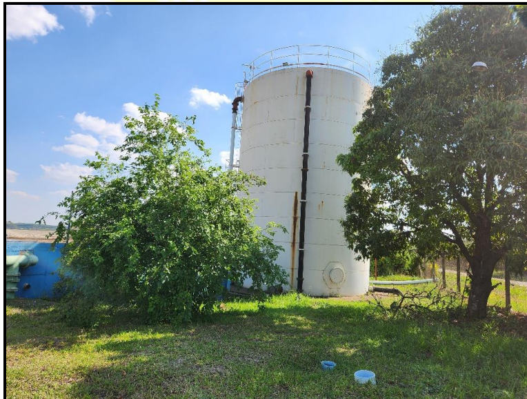
Figura 79 - Reservatório apoiado do Parque das Empresas
