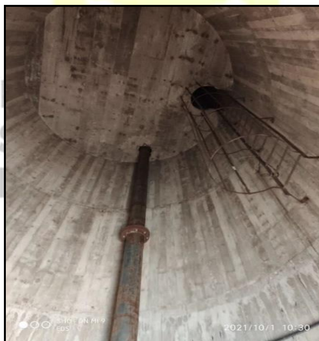
Figura 77 - Parte interna do reservatório do Chico Mendes
