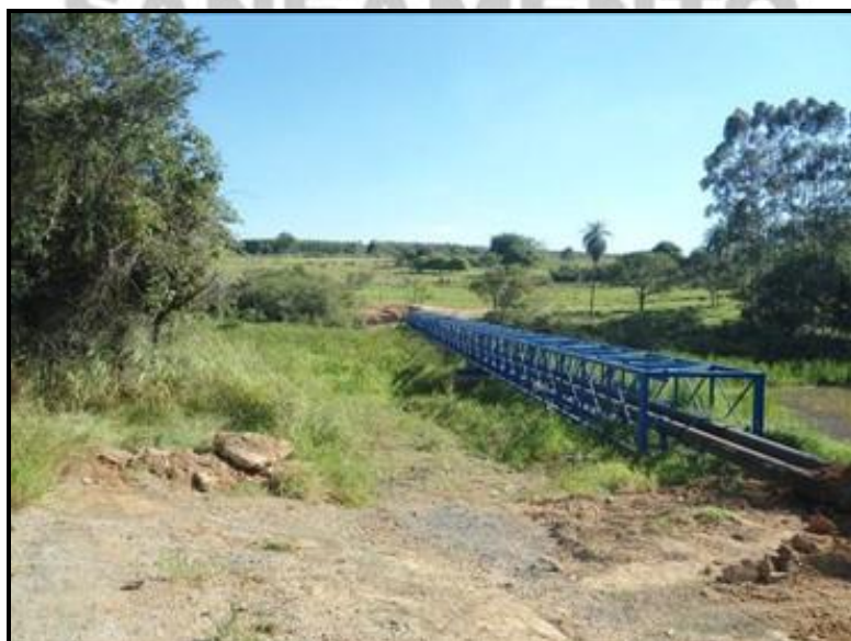
Figura 25 - Travessia das adutoras
