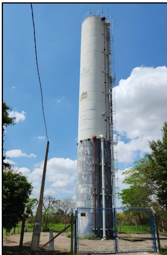
Figura 82 - Reservatório Martim Francisco
