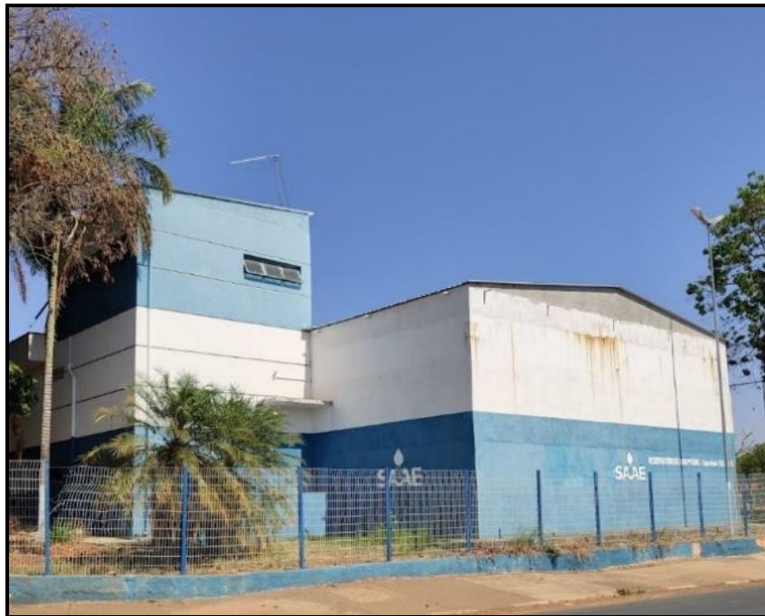
Figura 62 - Reservatório Catarino Marangoni
