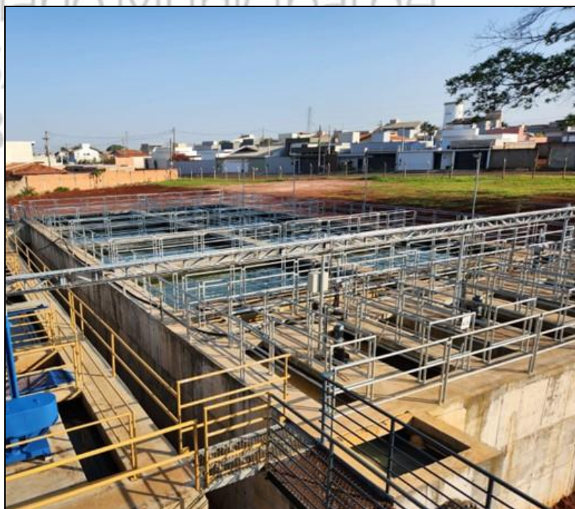
Figura 34 - Floculadores e decantadores da ampliação da estação
