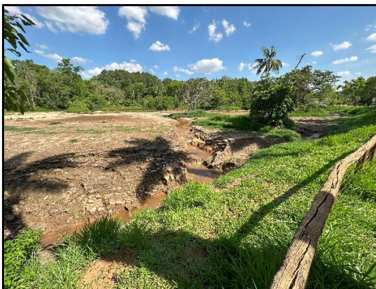
Figura 137 - Assoreamento na represa do Córrego Bela Vista
