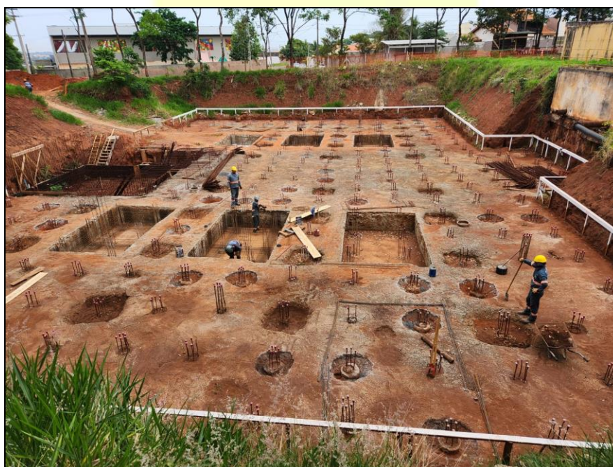
Figura 31 - Reservatório em construção – 5.000 m 3
