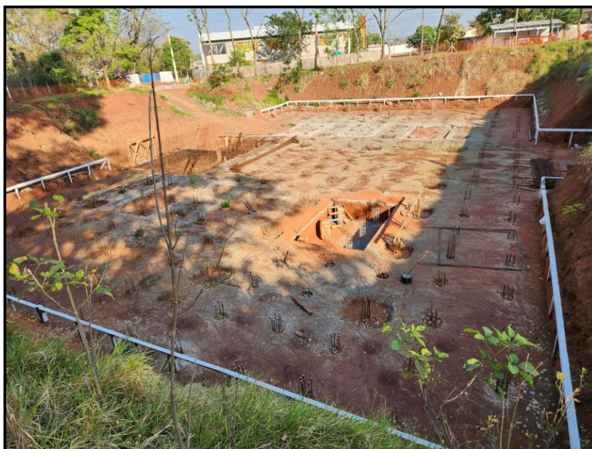
Figura 30 - Reservatório em construção – 5.000 m 3
