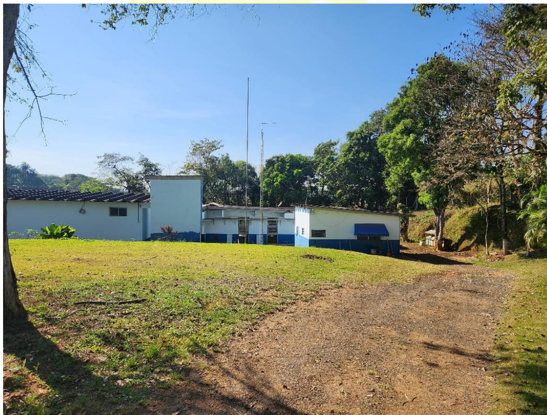
Figura 19 - Vista externa da EEAB
