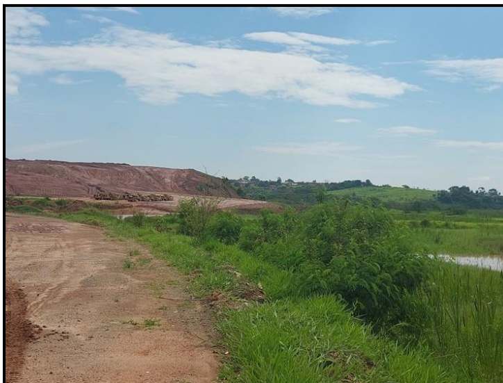
Figura 133 - Assoreamento no Rio Mogi Mirim devido a terraplanagem
