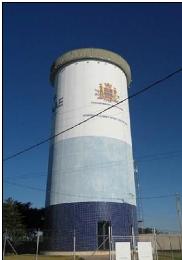
Figura 58 - Reservatório do Parque Real
