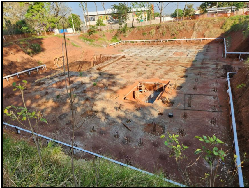
Figura 48 - Reservatório de 5.000 m 3 em construção
