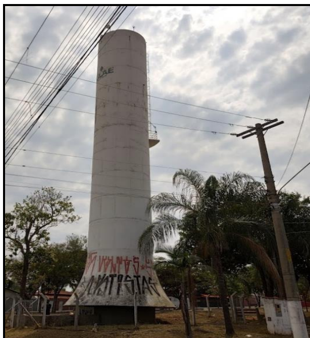
Figura 76 - Reservatório do Chico Mendes
