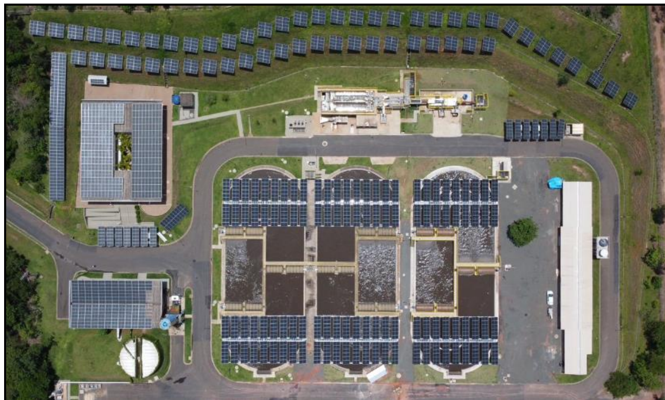
Figura 106 - Usina fotovoltaica da ETE de Mogi Mirim
