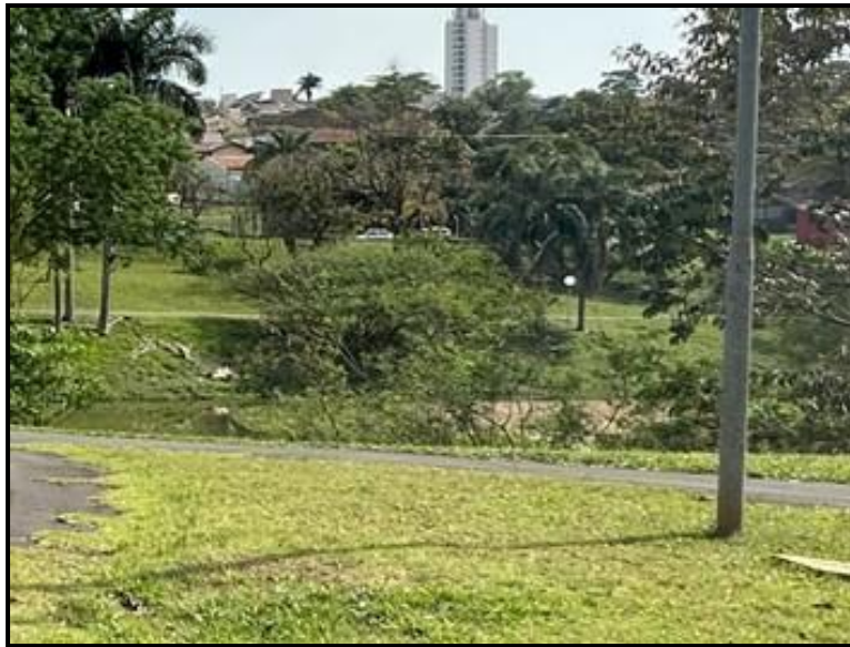
Figura 135 - Assoreamento no barramento do Córrego Lavapés
