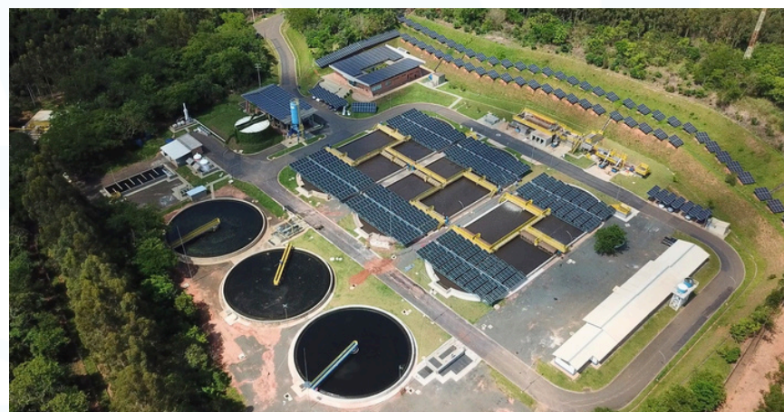
Estação de Tratamento de Esgotos (ETE) SESAMM - Serviços de Saneamento de Mogi Mirim
