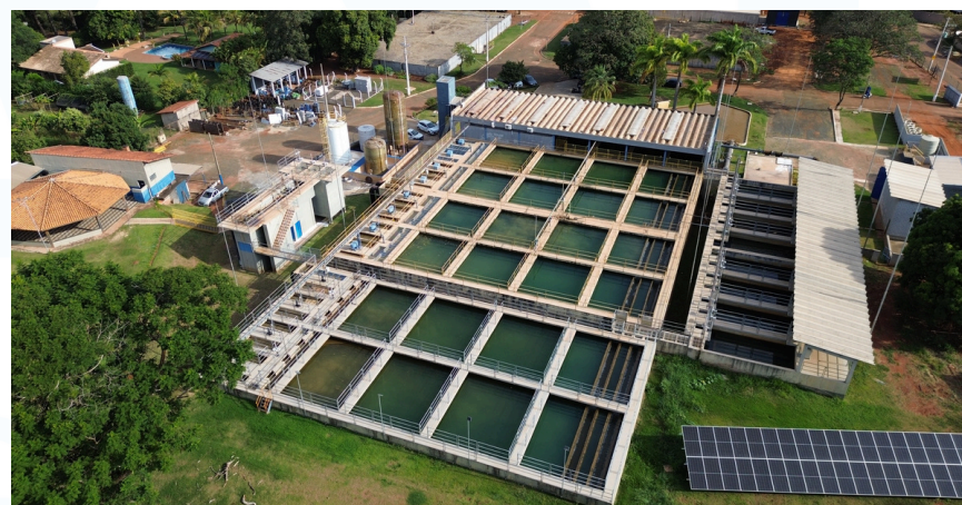
Estação de Tratamento de Água (ETA) de Mogi Mirim
